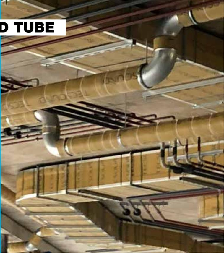
> Tecsound® Tube es un complejo insonorizante formado por lámina sintética de alta densidad y sin asfalto Tecsound®, unida a un filtro no tejido de poliéster de alta tenacidad, especialmente diseñado para usar como aislamiento acústico del ruido de bajantes en edificación.
