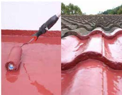
grasa, algas, polvo y materiales disgregados. El soporte debe ser consistente y estar limpio, seco y en buen estado.
